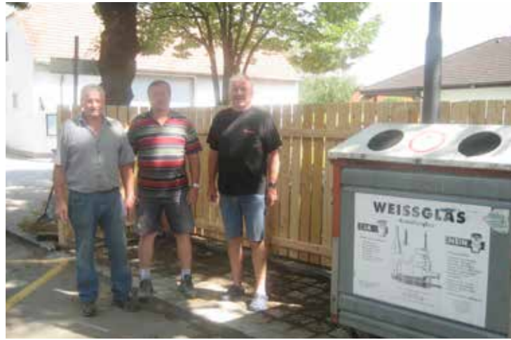
Neu gemacht: Eine Einhausung erhielt das Kleinsammelzentrum, das Material wurde von der Gemeinde bezahlt, die Arbeiten übernahm der Verschönerungsverein unter Mithilfe von Leopold Biegler und Franz Bieder.
